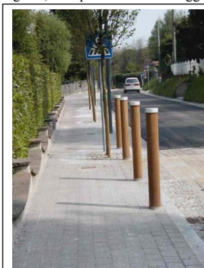
3. Il marciapiede e la corsia pedonale possono essere protetti da elementi di delimitazione ove lo spazio destinato al pedone sia scarso.
